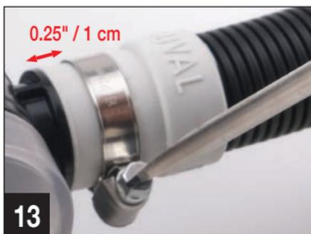
13. Überprüfen Sie, dass alle Metallschellen ca. 1 cm von den Enden entfernt sind und mit einem Schraubendreher fest angezogen wurden, damit wasserdichte Verbindungen gewährleistet sind.
